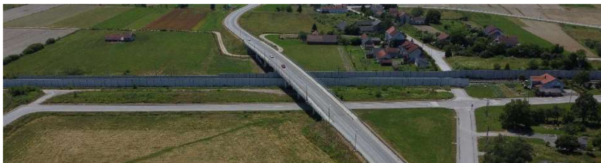
Fotografija D-6: Koridori kanala, prometnica i željeznice
